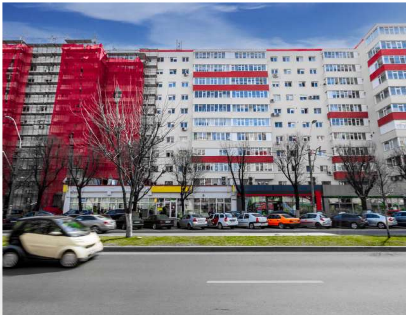
REABILITAREA TERMINCĂ A BLOCURILOR DE APARTAMENTE
