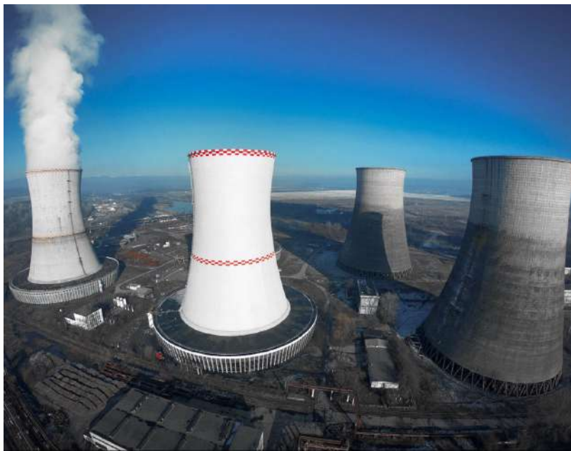
TURNURI DE RĂCIRE - REPARAȚII COMPLEXUL ENERGETIC OLTENIA
