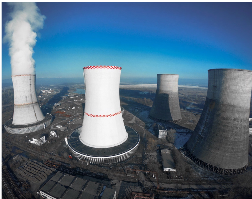
TURNURI DE RĂCIRE - REPARAȚII COMPLEXUL ENERGETIC OLTENIA
