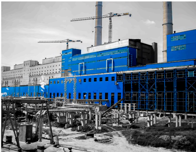
CENTRALA ELECTRICĂ, DROBETA-TURNU SEVERIN
